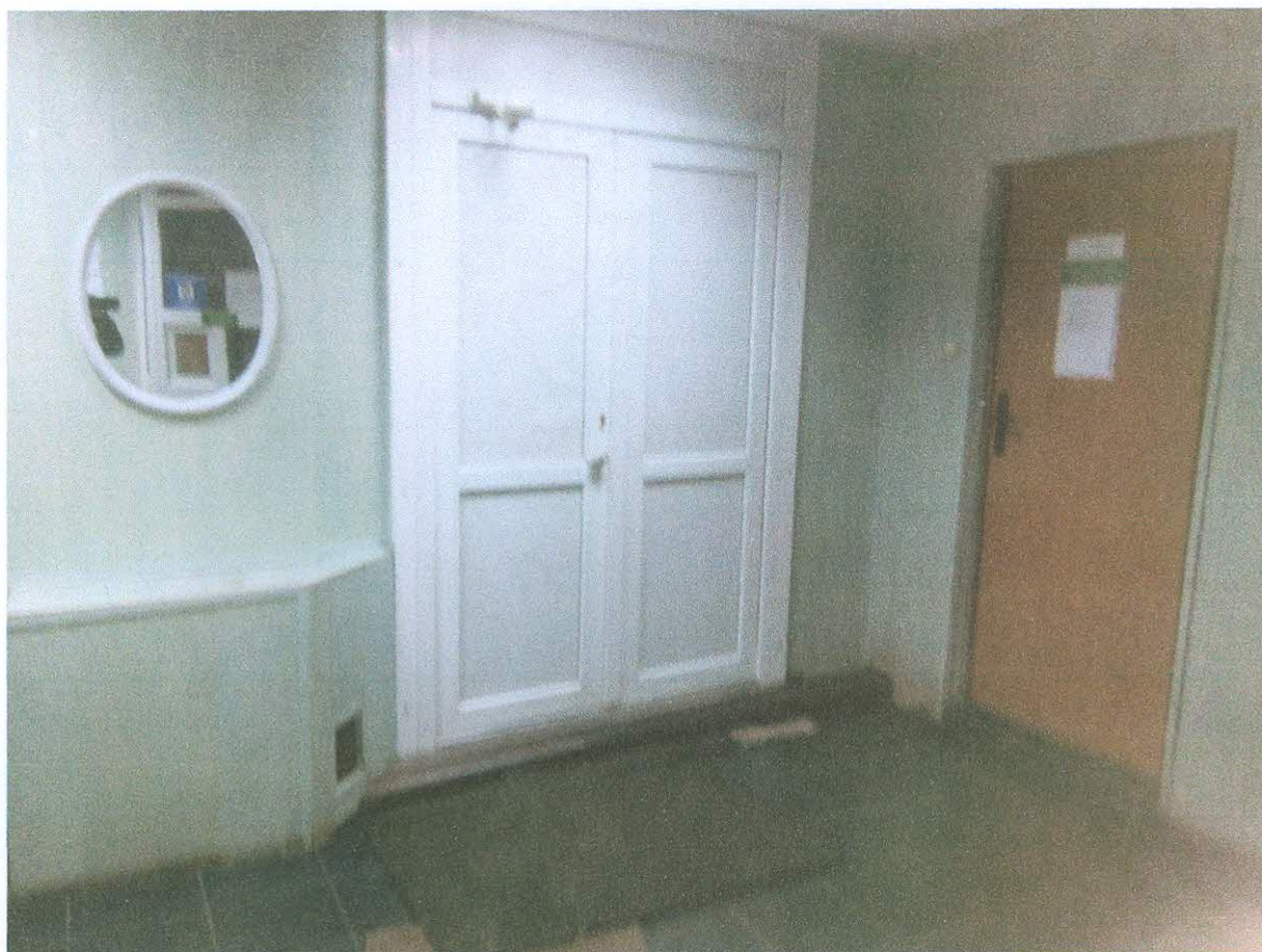
Фото 3 Выход в тамбур
